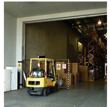
Rampas de carga
